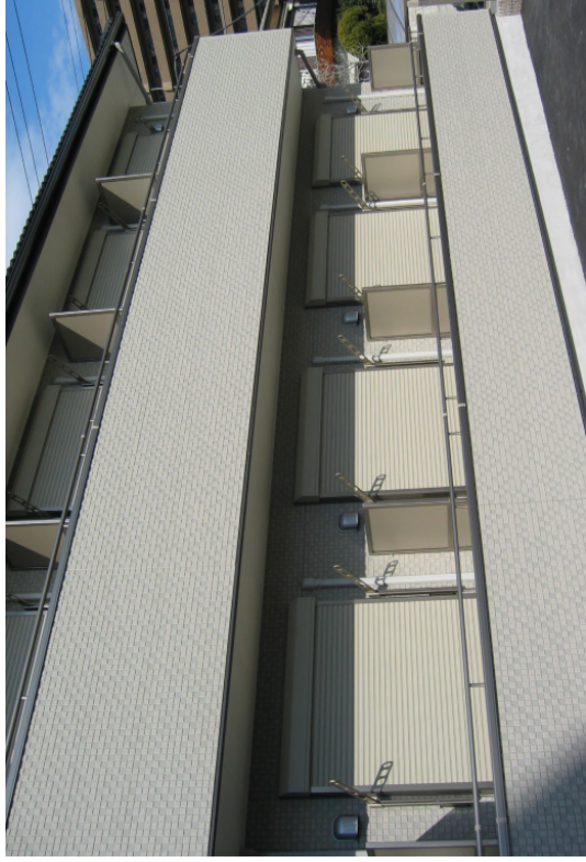
3階建て外階段に取付 (1段笠木 : オークムラウソ)
